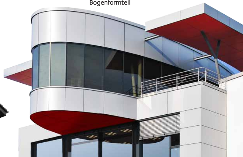
Verwaltungsgebäude in Berlin-Buch, pulverbeschichtetes Dachrandprofil und Fassadenbekleidung als Bogenformteil
