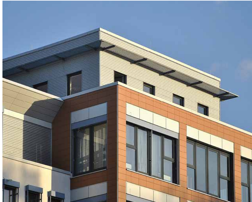
Einkaufszentrum STEP in Berlin-Pankow, Wellprofilfassade, pulverbeschichtete Fassadenbleikung und Mauerabdeckung
